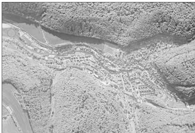
In Wendehausen wird in den nächsten beiden Jahren die Kläranlage Haselbach errichtet und ein Zulaufsammler gebaut.
