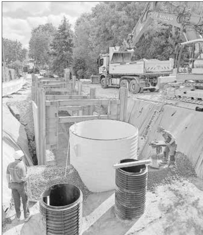
Die Etablierung einer modernen Ortskanalisation in Bickenriede sowie der Anschluss an die Kläranlage Schildbach zählt zu den aktuellen Bauprojekten des WAZ Obereichsfeld.
