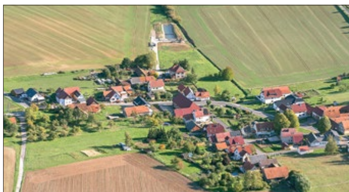
Maßgeschneidert für Schwobfeld: Die neue Kläranlage mit Schönungsteich
